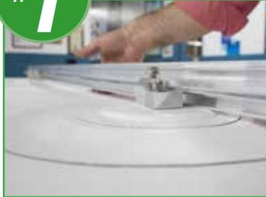
Pase a la siguiente sección de (7.5) pies, repita el paso 7, coloque el nuevo riel Color Snap® deslizando los conectores del riel en ambos rieles.
