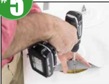
Instale el sujetador recomendado a través del techo y la plataforma (mín. De penetración for "para acero y 1" para madera) usando el medidor de profundidad provisto, permitiendo que el cabezal del sujetador se asiente firmemente en la tarjeta del medidor. No sobreexagere este cierre.
