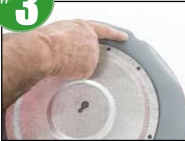
Levante la pestaña elastomérica e instale ocho sujetadores adicionales a través de la placa de acero MCP, golpeando las flautas superiores en la plataforma. No doble ni arrugue la membrana durante la instalación del cierre.
