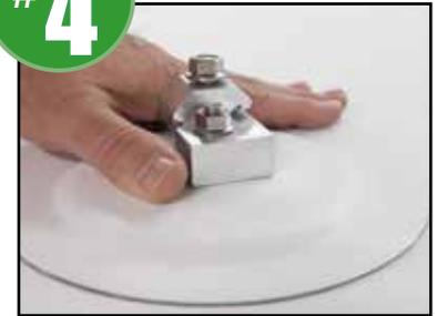
Materiales termoplásticos. (TPO, PVC, etc.): Suelde por calor la brida del MCP a la membrana del techo de acuerdo con las especificaciones del fabricante y selle los bordes según sea necesario.
